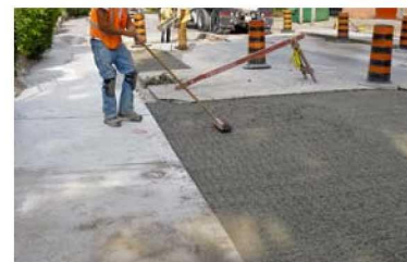
Pour new cement in place
